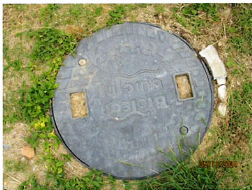
ภาพที่ 2-10 ระบบถังเกรอะ
