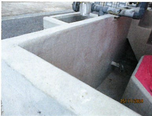
ภาพที่ 2-28 ขอบกัน (Dike) บุด้วยไฟเบอร์กลาส
