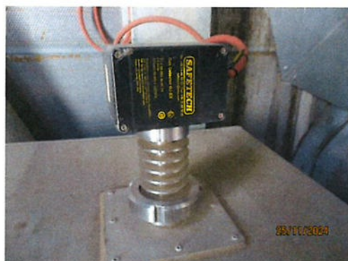
ภาพที่ 2-33 Gas Detector
