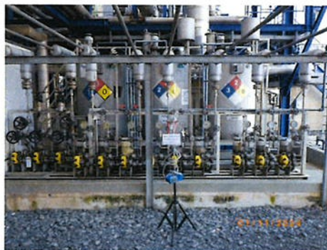
หน่วยเติมสารเคมีในหม้อน้ำ (Boiler Chemical Dosing)
